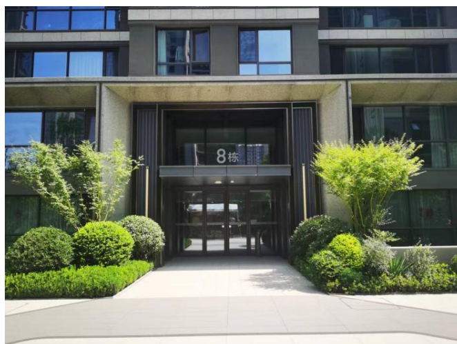
图 4.2.1-1 住宅单元门前的平坡出入口
